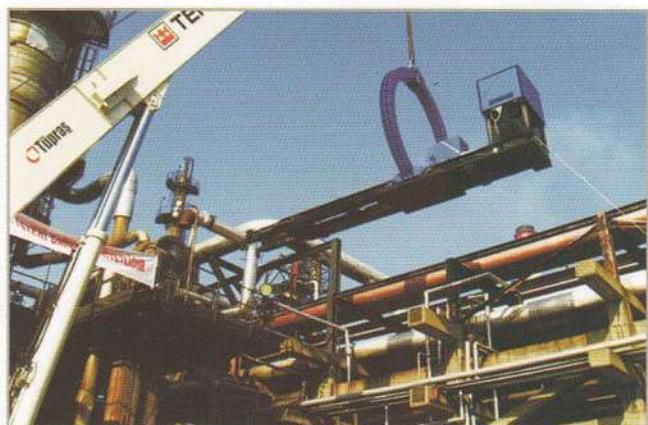
IDROJET – Ваш экстрактор: легкий, простой в эксплуатации и обслуживании, оснащен мощной кареткой способной вытянуть самые «упрямые» трубные пучки за одну операцию, как правило, менее чем за 15 минут. Все функции управления выполняются дистанционно с безопасного расстояния. И наконец у нас самый большой спектр машин в мире!
